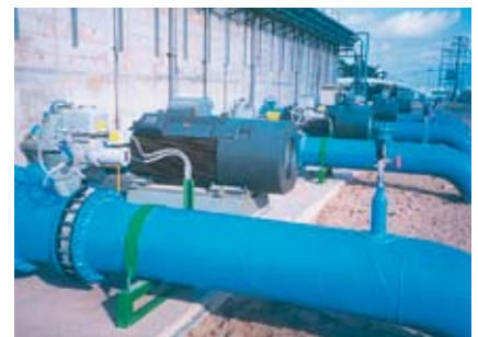
Suministro: HGF355, 290kW (390HP), 3.300V, 4 polos Aplicación: Bombas centrífugas
